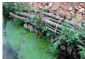
Figura 20 | Exemplo de faxinas vivas
