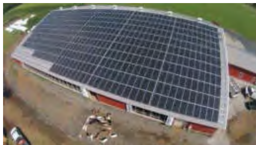
Figura 25 | Edifício com telhado em painéis fotovoltaicos
