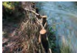
Figura 19 | Exemplo de entranchado vivo
