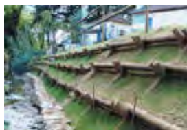
Figura 18 | Exemplo de uma grade viva
